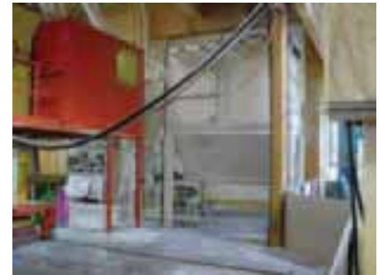
Patronenfilter mit Druckluftabreinigung für 6.000 m 3 /h mit Vorzyklon
