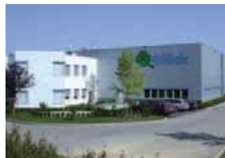
Neubau der Firma Glück in Wolfers bei Steyr/OÖ
