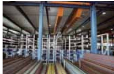
Seitenansicht des UNIBLOC A-Stapeljochlagers mit Lagerplätzen für Rechteck-Hohlprofile.
